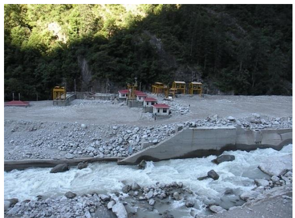
Vishnuprayag Barrage Site
