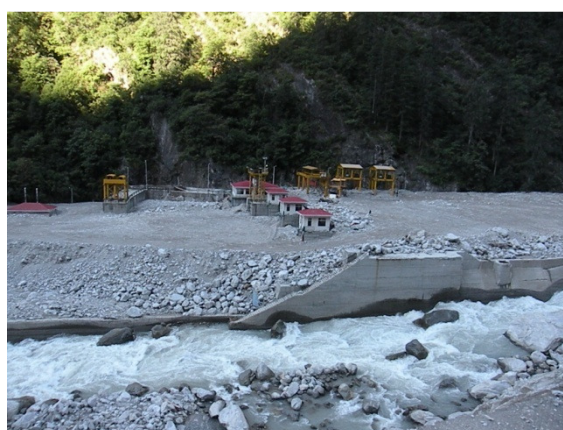
Vishnuprayag Barrage Site
