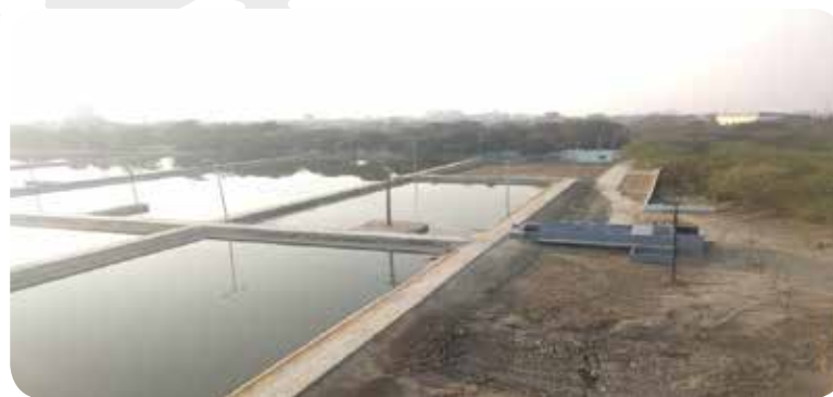
Vrindavan STP- 4MLD
