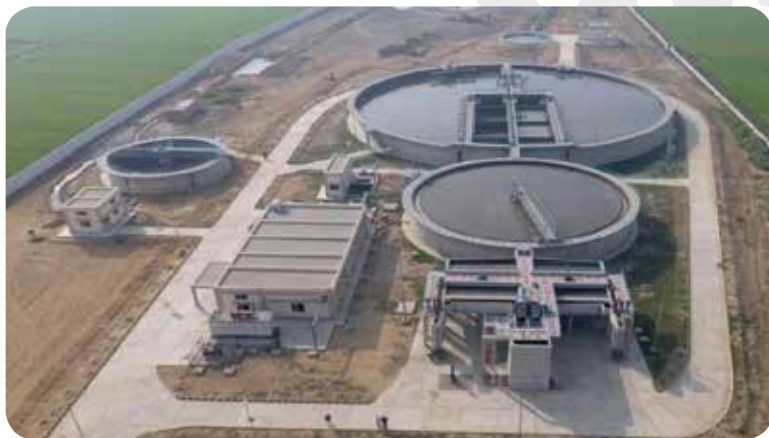
Panipat- 20MLD STP
